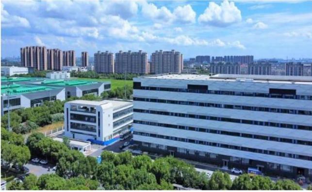
图 36: 公司二期项目新厂房即将建成投用
