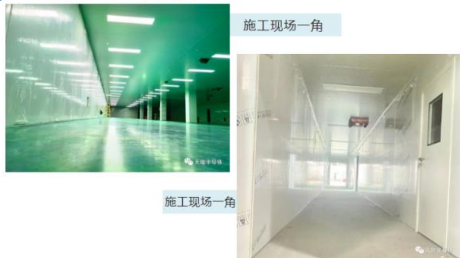
图 38. 建设中的 MPCVD 生产车间
