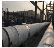
左图： 临港经济开发 区中压蒸汽主 管节能改造
