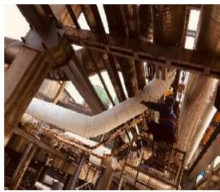
左图： 华昌化工 中压蒸汽管 线节能改造
