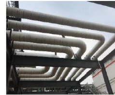
左图： 临港经济开发 区中压蒸汽主 管节能改造
