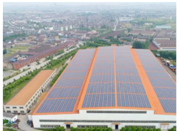
图 3: 应用案例江苏沃得 36.8MW 分布式光伏电站
