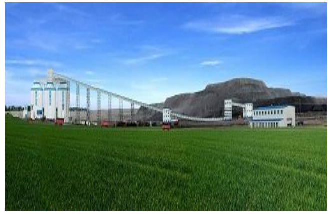
图26: 南露天煤矿地面生产系统
