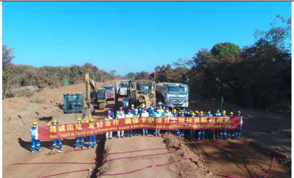
图25 卡萨项目开工现场
