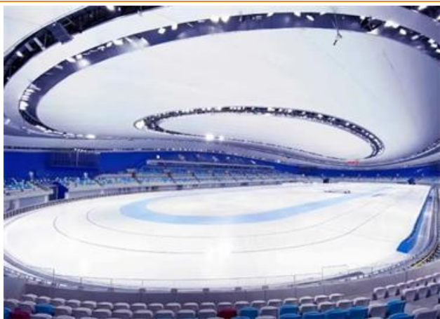
图 34：北京冬奥会国家速滑馆项目
