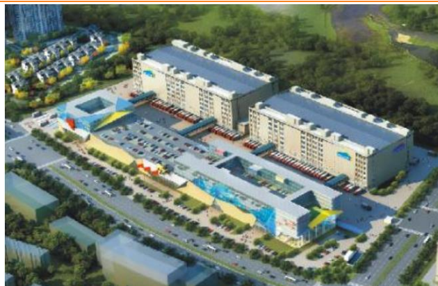
图 33：武汉万吨华中冷链港项目
