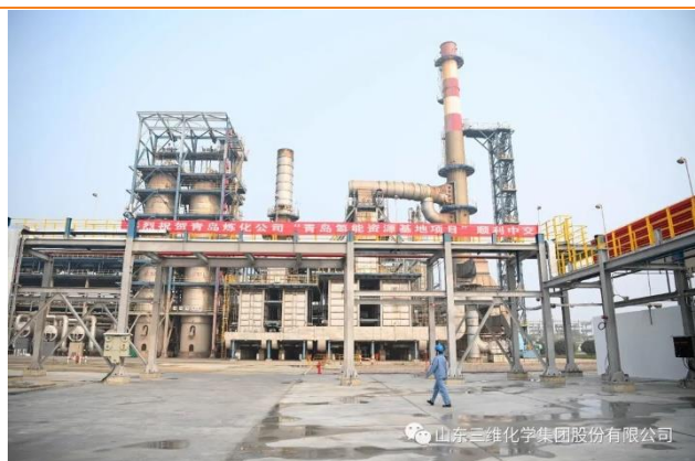
图 17：青岛炼化公司青岛氢能资源基地项目
