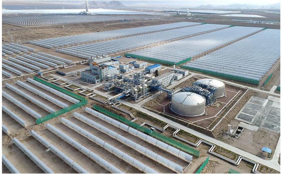
图 29：中广核德令哈 50MW 光热项目
