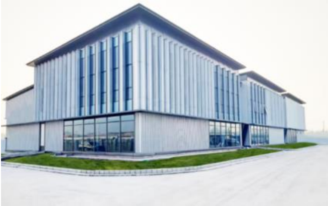
图 34：锡山再生水厂外观图
