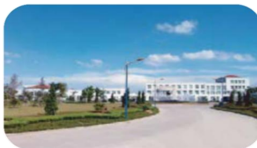
图 14：华东区域例子：杭州七格污水处理厂
