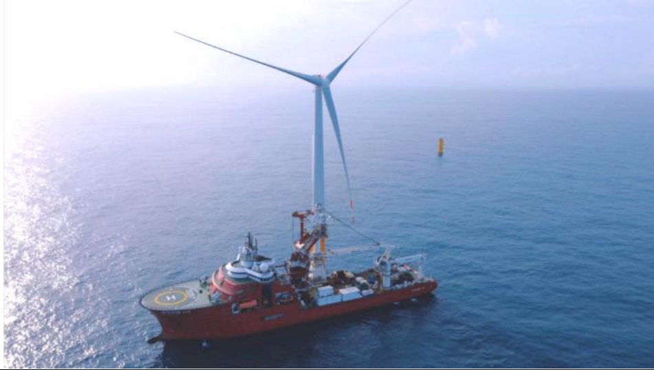
图 50：“海洋石油 286” 在进行海上安装作业
