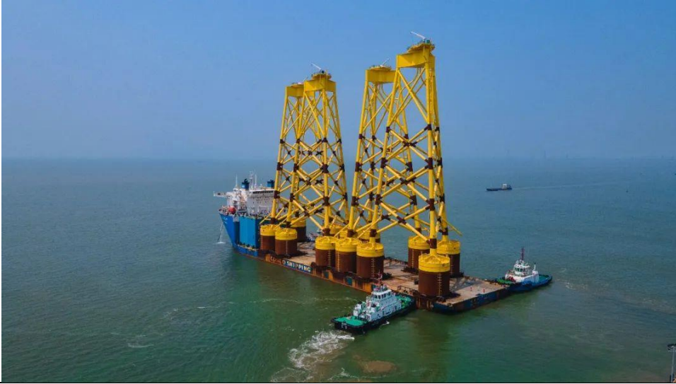
图 48: Seagreen 项目风电导管架
