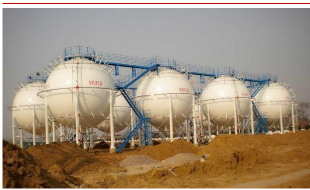
图 24: 洛阳宏力化工厂 400m 3 异丁烷薄壁球罐
