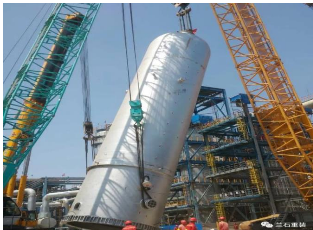
图 15: 加氢反应器 (板焊式)
