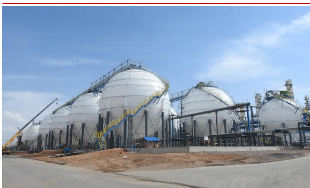
图 23: 神华宁煤球罐工程
