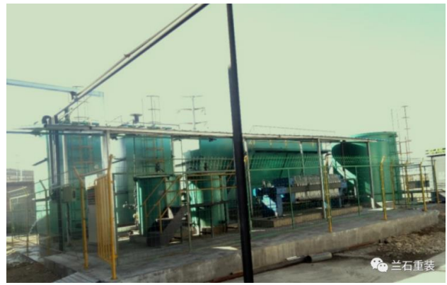
图 31：污水处理厂扩容增量提标改造项目
