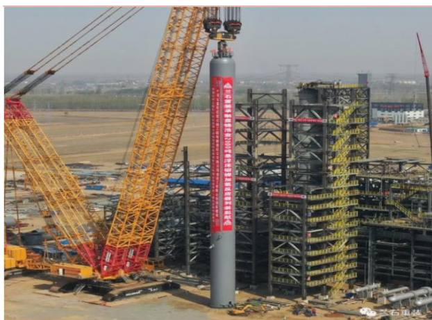
图 14: 加氢反应器 (锻焊式)
