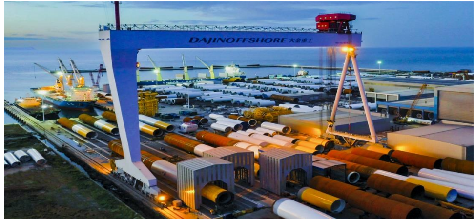
图31.凹槽码头配合龙门吊进行装船作业
