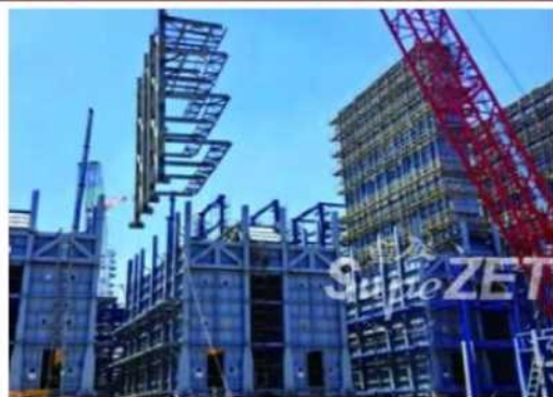
图表 23: 盛虹石化 110 万吨/年乙烯装置裂解炉
