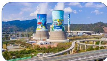
广东粤电大埔电厂二期电除尘+MGGH
