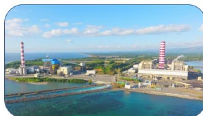
菲律宾马辛洛克二期2×350MW机组配套电除尘器EPC
