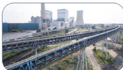
大唐托克托电厂输煤管带机输送设备工程
