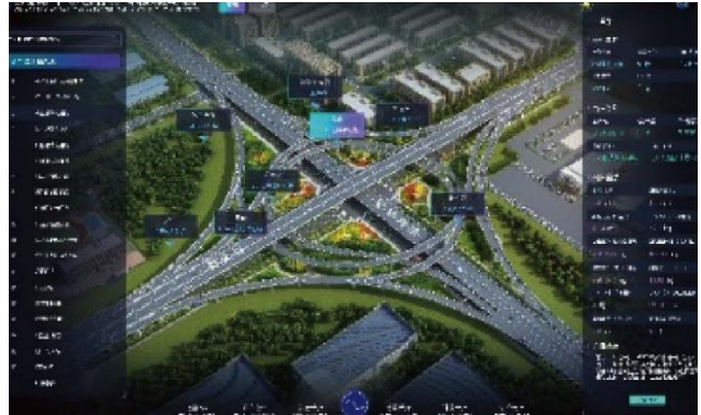
图 35：兰州新区经三十三路与 G341 线立交工程项目
