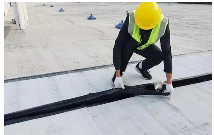
图 13: 高分子防水卷材施工
