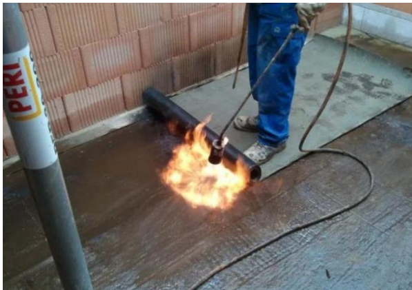
图 12: 明火热熔法施工
