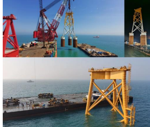
图 21：长乐外海 C 区海上风电场基础运输-起吊-沉贯施工
