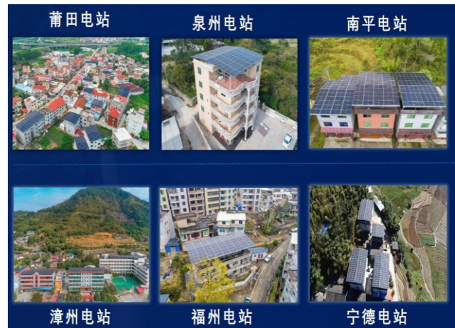
图 35：永福股份户用光伏电站系统集成产品“整县推进”案例
