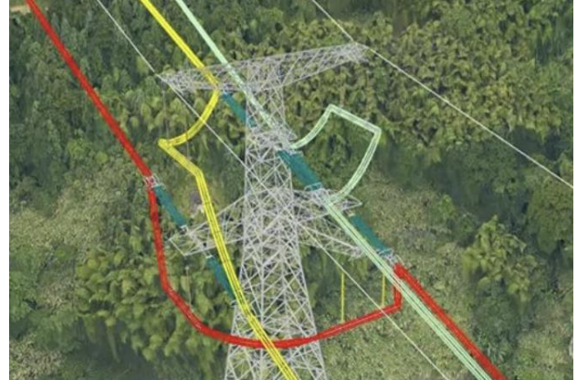
图 45：福州至厦门 1000kV 特高压输电通道
