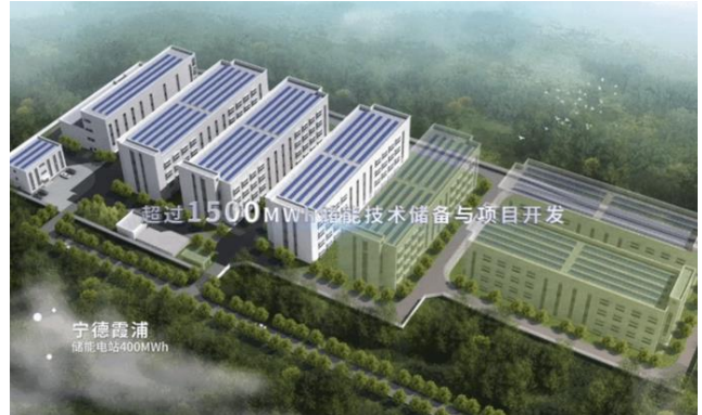
图 25：宁德霞浦储能项目
