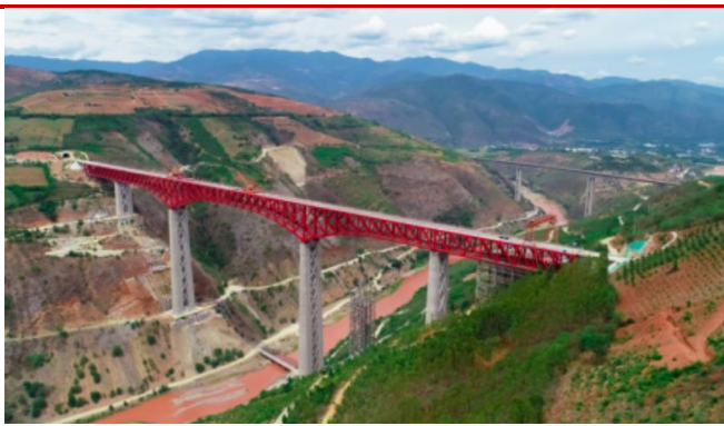
图 34 中老铁路元江特大桥上安装了基于北斗的桥梁健康监测系统，助力桥梁监测、精准施工
