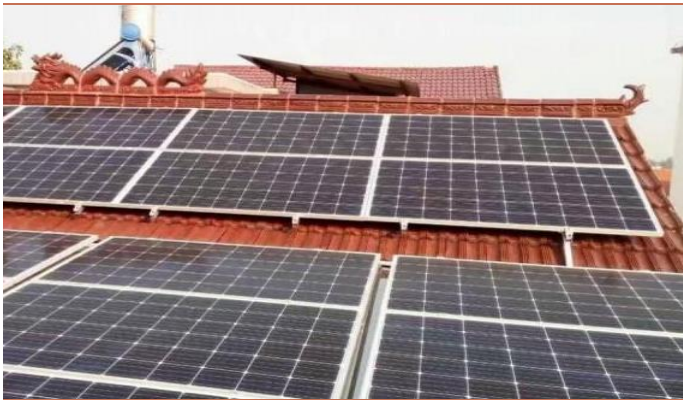
图 4：BAPV—屋顶光伏（无建筑物功能）
