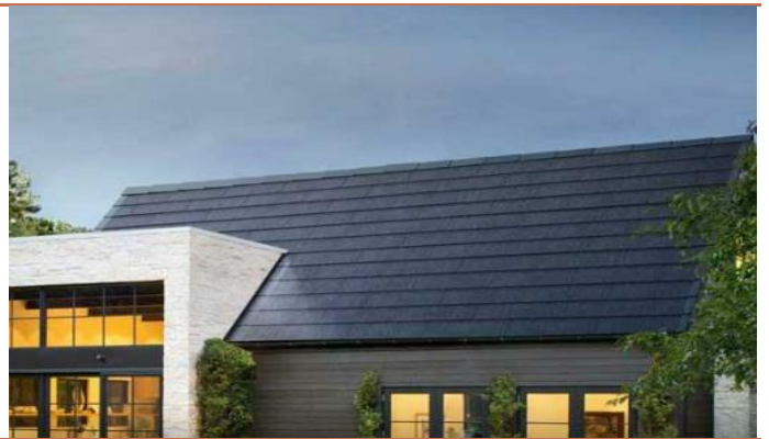
图 5：BIPV—与建筑一体，建筑集成
