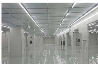
兰考裕富精密洁净室工程
