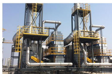
苏州矽品科技无尘室工程
