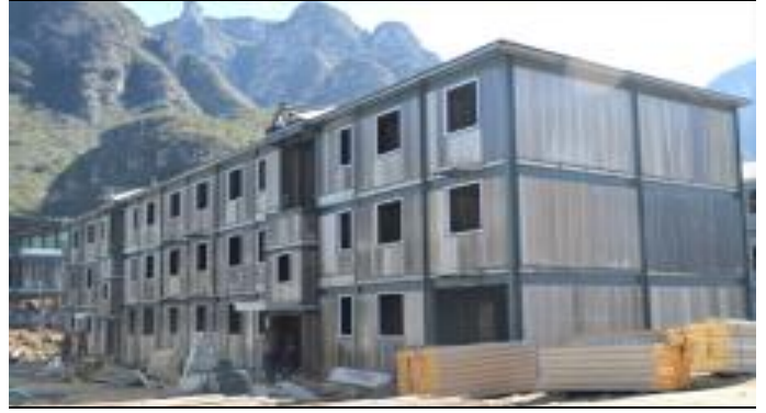
图6 结构装配式建筑示例
