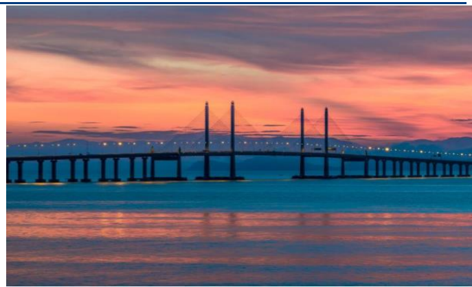
图表 11 马来西亚槟城第二跨海大桥项目
