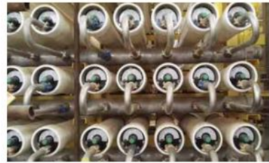
华能集团某电厂锅炉补给水系统
