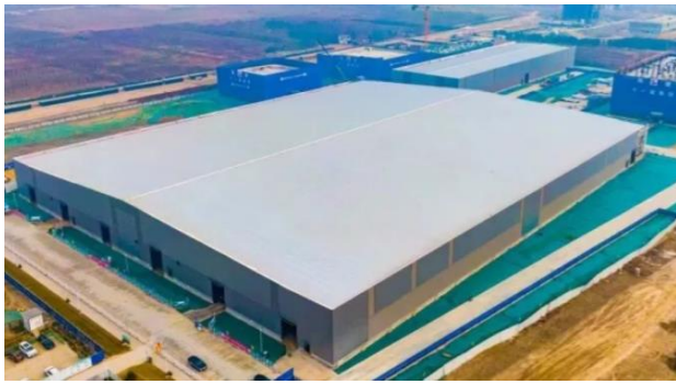
图27 秦川集团高档工业母机创新基地主体厂房
