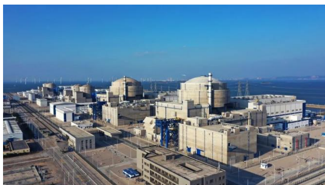
图 18: “华龙一号”示范工程第 2 台机组
