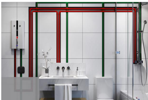
图11：PPR 管的布线情况
