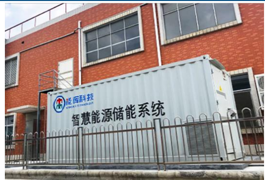
图表40：珠海用户侧 500KW/1MWh 智慧能源储能系统梯次利用示范项目
