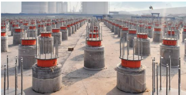
图15.公司中标河北省唐山市中海油 LNG 隔震项目
