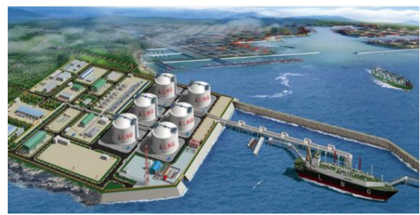
图16.公司与中石化联合完成天津 LNG 隔震项目
