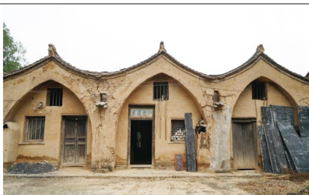
图 17：甘肃庆阳地区土坯箍窑
