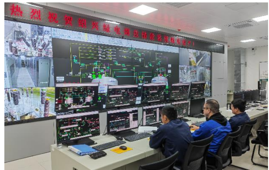
图 42: 绍兴绿电熔盐储能示范项目试运行
