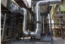
依据原理: 利用锅炉烟气含氧量较低的特点, 兼顾物料流化条件下还原性气氛构建
