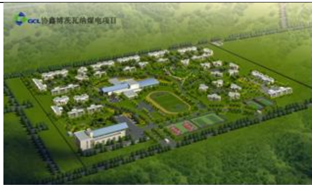
图24 协鑫博茨瓦纳煤电一体化生活配套园区项目
