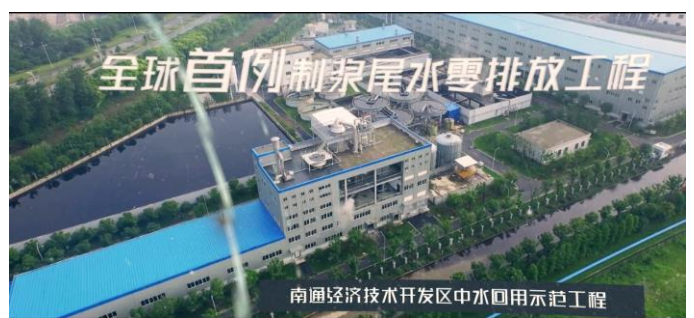
图27 公司打造全球首例制浆尾水零排放工程
