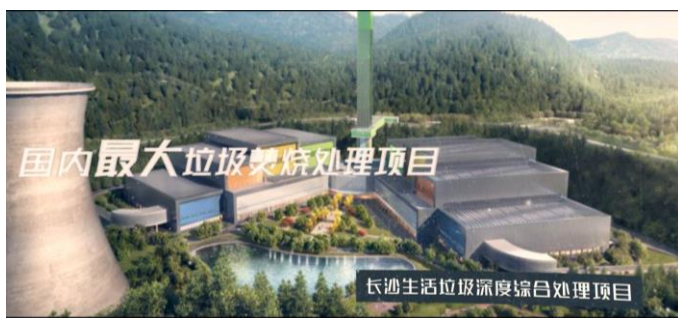
图26 公司打造国内最大垃圾焚烧处理项目
