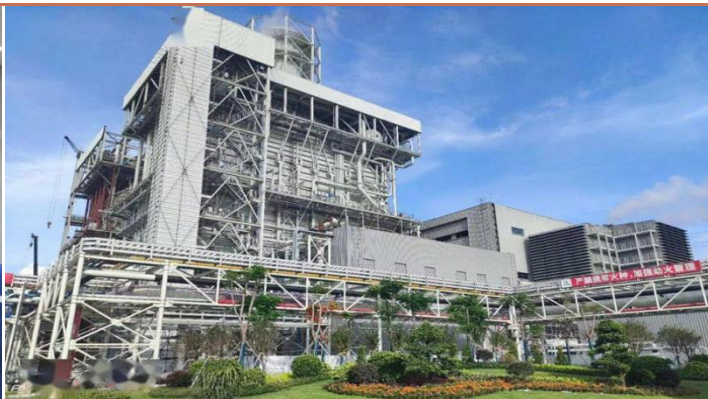
图 9：京能集团钰海燃气-蒸汽联合循环热电联产机组
