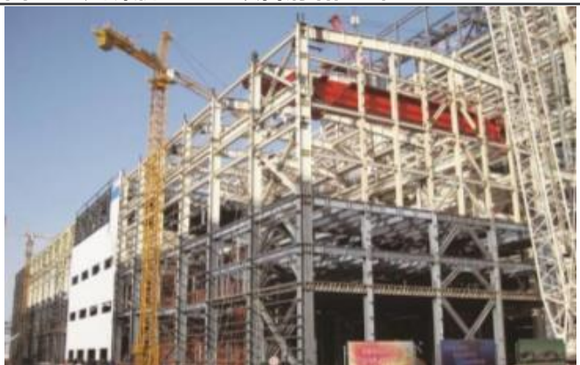
图5：公司案例 c-工业项目钢结构工程
