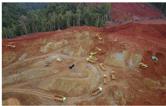
图 28：印尼 Hengjaya 矿区
