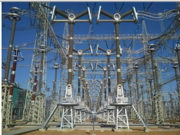
图 28：公司研制的世界首台 1100kV 滤波器组断路器
