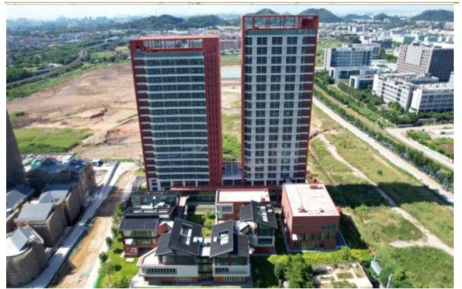
图 32：南方传媒中心现场图片
