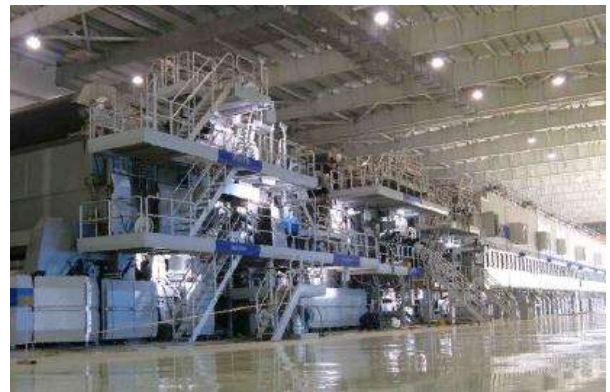
图 22：新闻造纸车间建设安装工程
