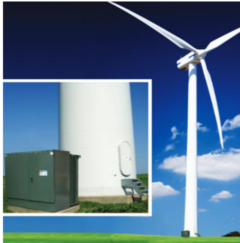
图表 21: 油浸式变压器示意图
