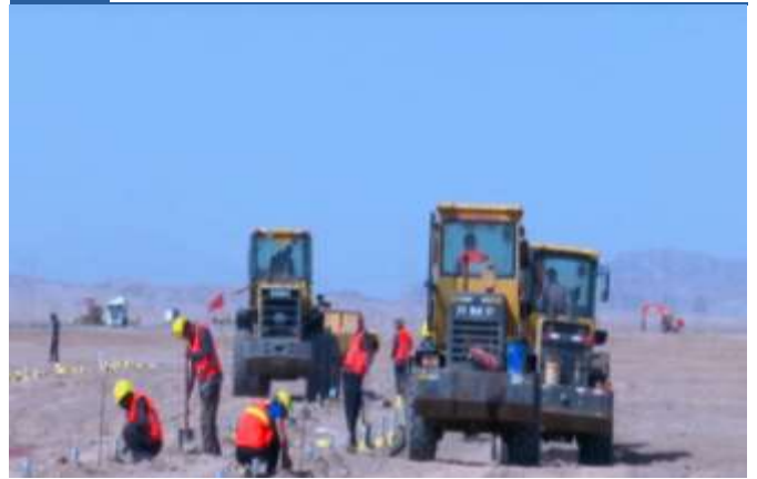
图 12: 新华水电莎车县 20 万千瓦项目施工现场
