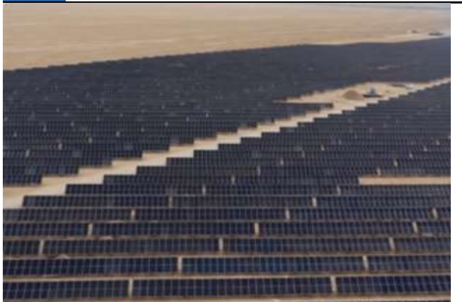
图 11: 新华水电莎车县 20 万千瓦项目
