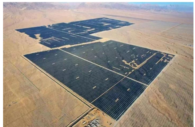
图 69: 华电德令哈西出口光储氢一体化示范基地一期项目
