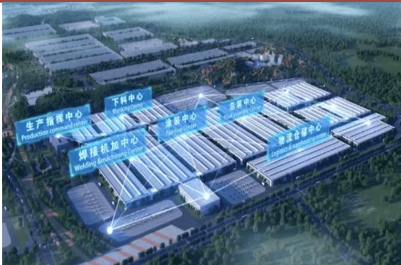
图58.中联智慧产业城首开项目——土方机械园区
