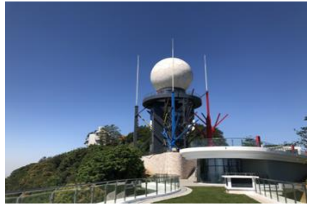
图 47：新一代双偏振天气雷达
