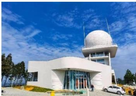
S 波段双偏振相控阵天气雷达
