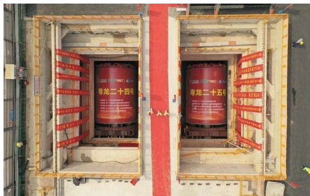
图11: 公司盾构机用于广州地铁建设
