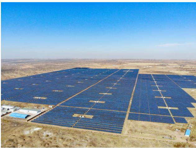
图 1：陕西定边 110MW 光伏电站
