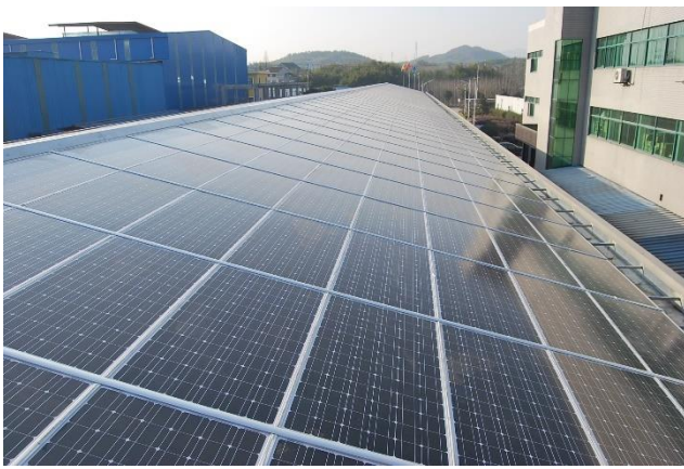
图 23: BIPV 屋顶
