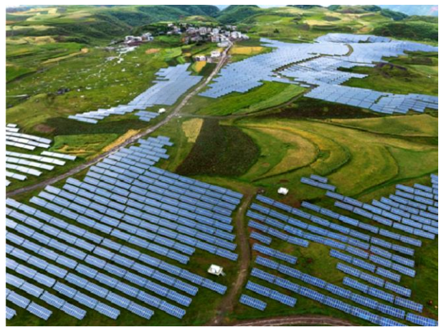
图 2：云南昭通 30MW 光伏电站
