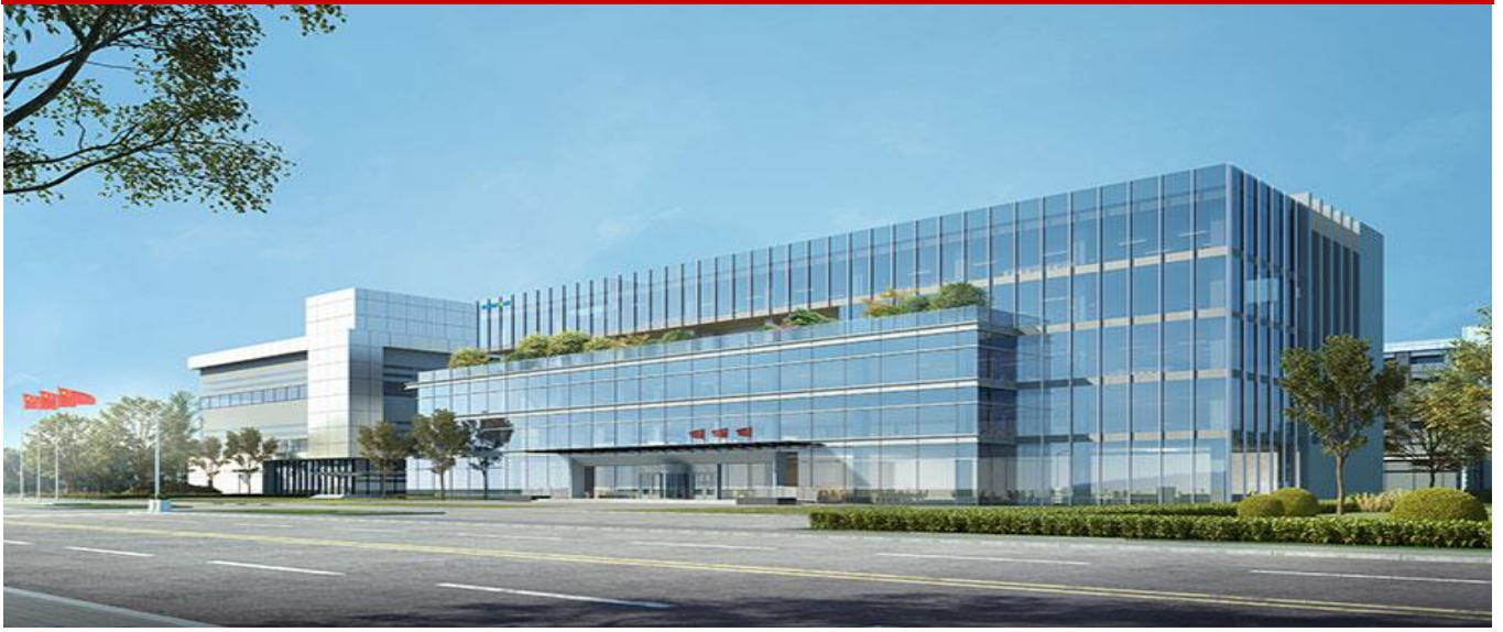
图 9 芯源微上海临港新厂区
