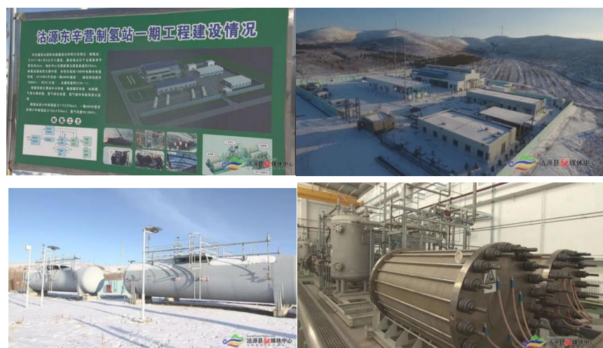
图 45：2020 年底，沽源项目完成设备安装
