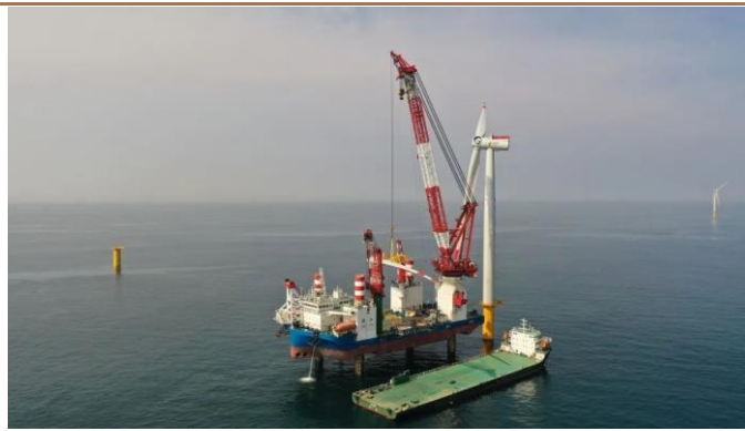
图 43: 国家电投揭阳神泉一（二期）海上风电项目
