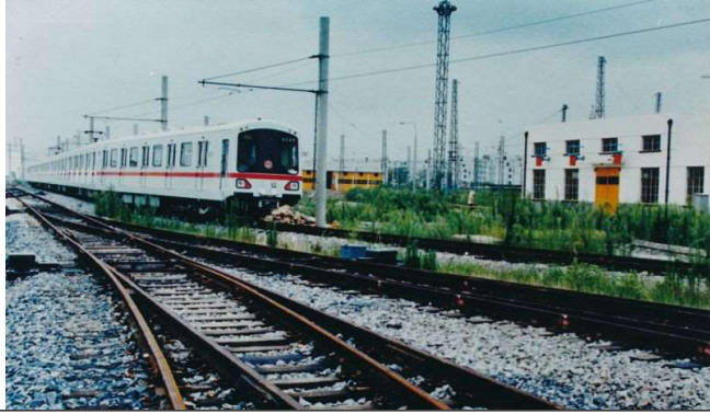
图 5 公司轨道交通代表工程-上海地铁 1 号线（全国市政工程金杯奖、詹天佑奖）
